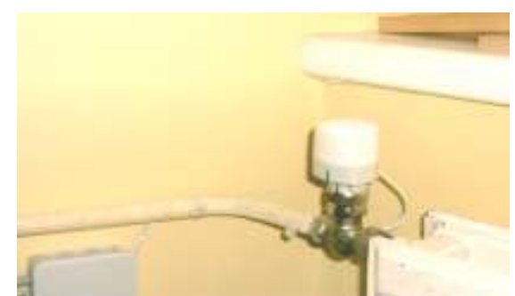
links: Temperaturfühler im Klassenraum rechts: Heizraum, Hintergrund neuer Brennwertkessel
